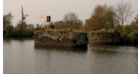
Filary nieistniejącego mostu
