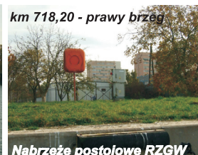
Km 718,20 - prawy brzeg Nabrzeże postojowe RZGW
