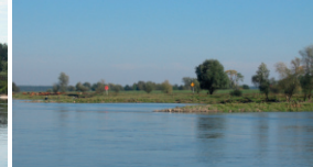
Zabudowa regulacyjna - ostrogi
